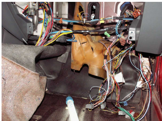
Ilustracja 29: Przerobiona elektryka, ale jeszcze nie owinięta
